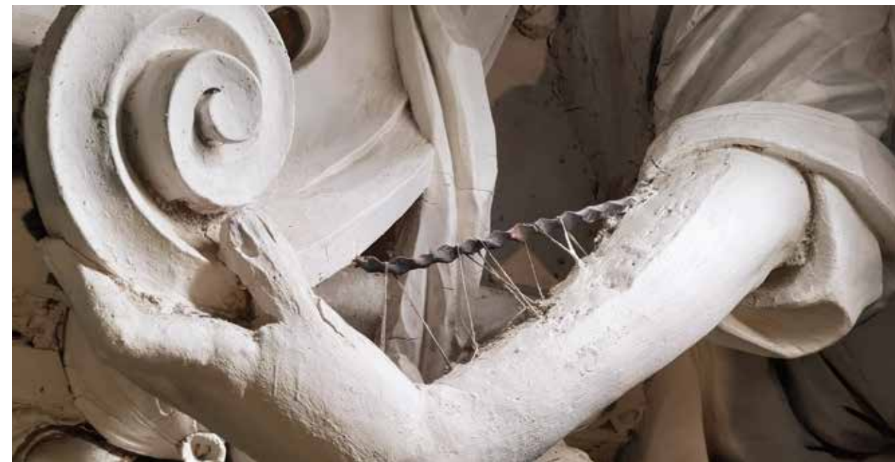
fig. 15 Carona (Lugano), Madonna d'Ongero, particolare dell'armatura di un angelo.
